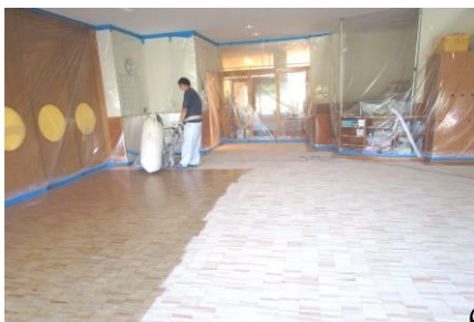
ほし1組・そら2組の床の修繕 工事を行いました。
