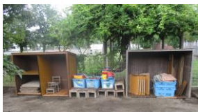
新しい遊具棚と日よけを設置しました
